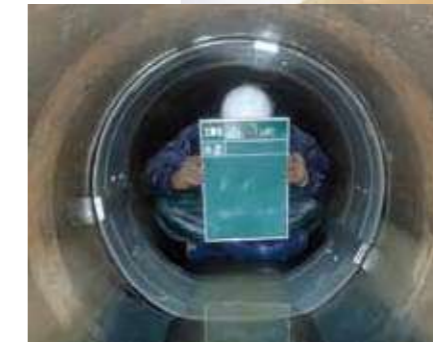
スナップロック工法ML 施工後
