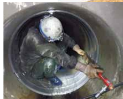
円形管ステンレススリーブ拡径状況
