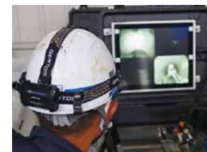
遠隔施工装置の作業状況(テレビモニター)
