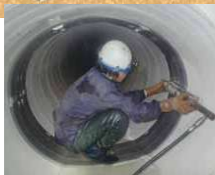
楕円管ステンレススリーブ拡径状況
