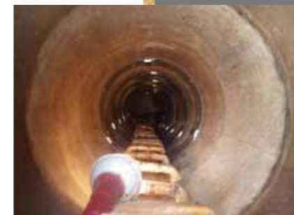
マンホール目地部連続施工
