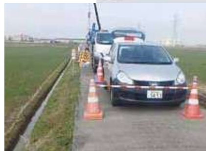
農水用水地域での施工状況
