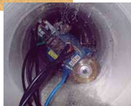
誘導目地切削状況
