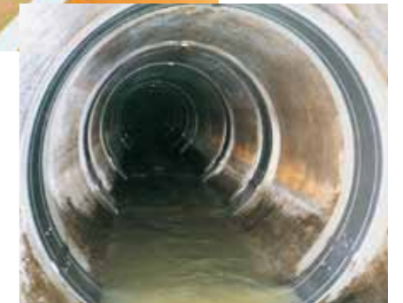
スナップロック工法ML 施工後
