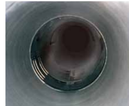
スナップロック工法S 施工後
