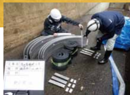
施工前材料確認状況
