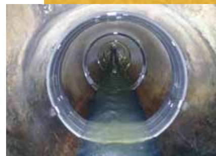
管きよ継手部連続施工
