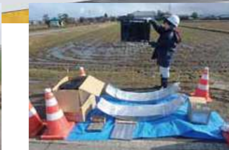
施工前材料確認状況
