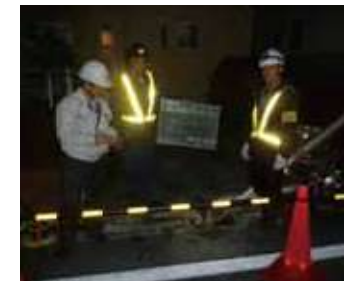
夜間 安全・施工パトロール
