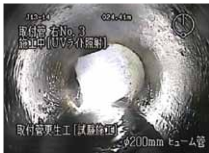
光硬化施工(本管側)
