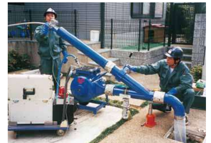
施工状況(公共まず)
