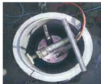
施工状況(小型まず)
