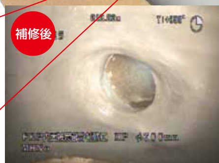
取付管管口部
