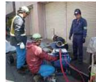
指導員による施工管理チェック
