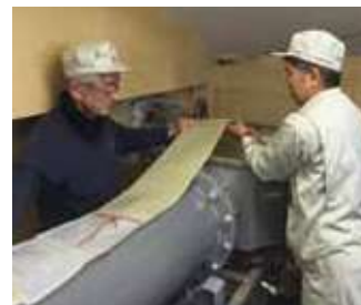
含浸材料の挿入
